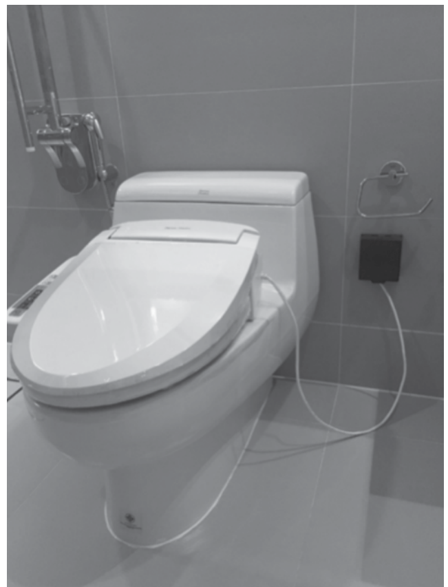
▲ รูปแสดงการติดตั้งเต้ารับเพื่อใช้ฝารองนั่งไฟฟ้าที่มีความปลอดภัย
