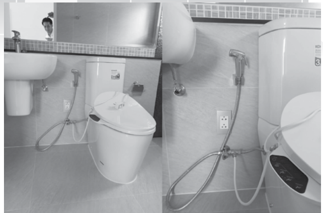
▲ รูปแสดงตำแหน่งเต้ารับที่โครงการเตรียมไว้ให้เพื่อใช้ฟารองนั่งโกส่วมไฟฟ้า
