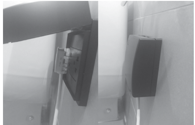
▲ รูปแสดงการดัดแปลงหัวเต้ารับเพื่อให้สามารถปิดฝาเต้ารับกันน้ำได้ขณะใช้งาน
