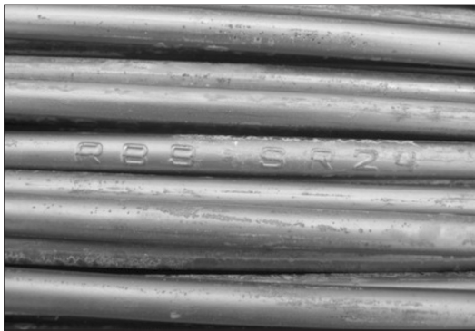
รูปภาพแสดงตัวพิมพ์บนผิวเหล็กเส้นกลมระบุว่าเป็น RB9 SR24
