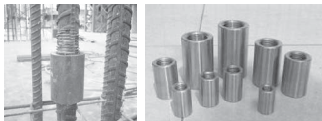
รูปการต่อเหล็กโดยใช้ข้อต่อเกลียว (Coupler)
