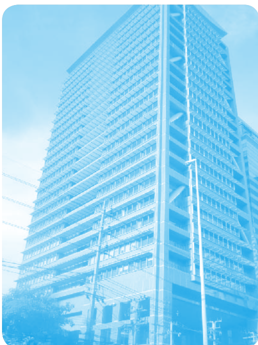
รูปอาคารที่ใช้กระจกตกแต่งภายนอกโดยรอบ
