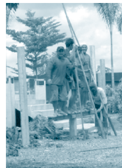
รูปภาพแสดงอุปกรณ์แท่นขย่มเสาเข็มและการใช้งานในงานตอกเสาเข็ม
