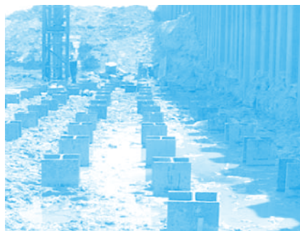
รูปภาพแสดงการใช้เสาเข็มเหล็กในการทำงานโครงสร้างใต้ดิน
