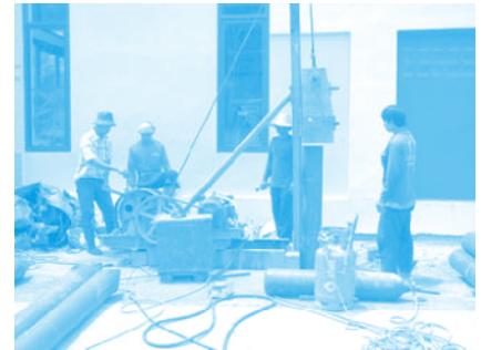
รูปภาพการใช้ปั้นจั่นตอกเสาเข็มเหล็ก
