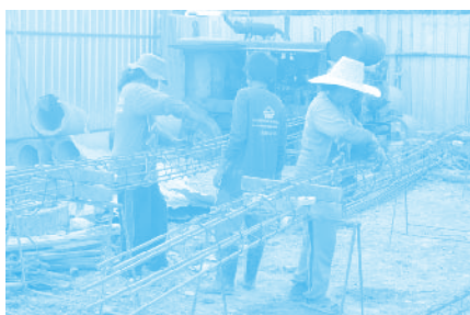
รูปภาพ แสดงเหล็กเสริมงานเสาเข็มเจาะระบบแห้ง
