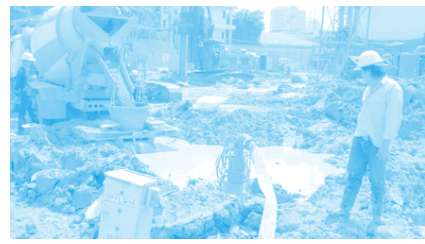
รูปภาพ งานการเทคอนกรีตงานเสาเข็มเจาะระบบเปียกซึ่งมีการใช้ปั๊มดูดสารละลายเบนโทไนท์เพื่อนำไปไว้ในถังพัก
