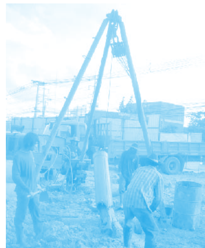
รูปภาพ การเทดินที่เจาะออกจากการเจาะดินในงานเสาเข็มเจาะระบบแห้ง
