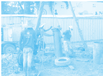
รูปภาพ การต่อท่อปลอกเหล็กเพื่อป้องกันดินพัง งานเสาเข็มเจาะระบบแห้ง
