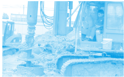
รูปภาพ การเจาะดินงานเสาเข็มเจาะระบบเปียก
