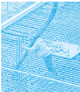
▲ รูปภาพแสดงการใช้งานท่อส่งคอนกรีตแบบยืดหยุ่น
