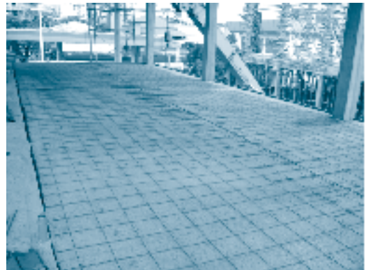
▲ รูปที่ 5 การเสริมเหล็กเพื่อรอเทคอนกรีตทับหน้า
