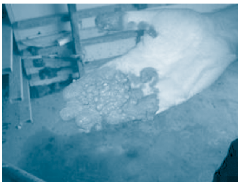
▲ รูปที่ 6 น้ำปูนผสมเม็ดโฟมที่ใช้ในการ grout
