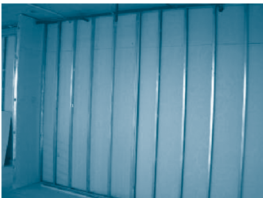
▲ รูปที่ 1 แสดงการติดตั้งโครงคร่าวและแผ่นไฟเบอร์ซีเมนต์ไปแล้วด้านพร้อมติดตั้งงานระบบในผนัง
