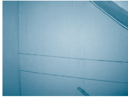
▲ รูปที่ 9 ผนัง solid drywall ที่ดำเนินการแต่งสีเสร็จแล้วและแสดงแนวรอยต่อกับคานโครงสร้างอาคาร
