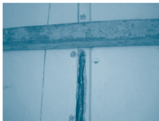
▲ รูปที่ 7-8 น้ำปูนที่ไหลออกจากรูที่แสดงระดับของน้ำปูนในผนัง
