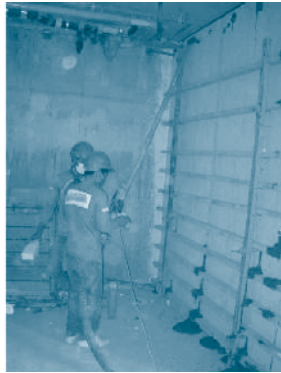
▲ รูปที่ 4-5 แสดงการทำงานในการ grout น้ำปูน
