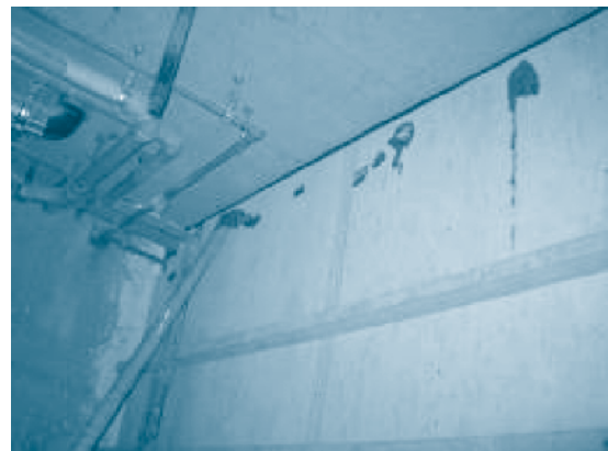
▲ รูปที่ 3 แสดงรูปที่ใช้ grout น้ำปูน
