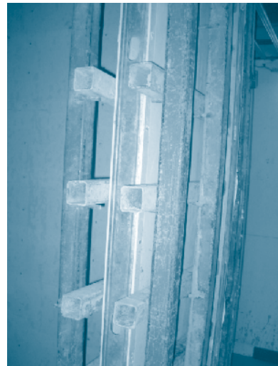
▲ รูปที่ 2 แสดงการติดตั้งชุดกล่องเหล็กยึดค้ำยันผนัง
