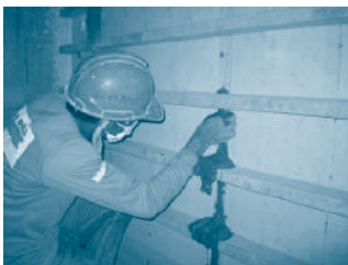
▲ รูปที่ 7-8 น้ำปูนที่ไหลออกจากรูที่แสดงระดับของน้ำปูนในผนัง
