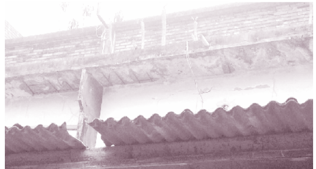
รูปที่ 1 แสดงสภาพความเสียหายของพื้นยื่นบริเวณท้องพื้น
