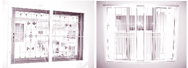
รูปที่ 3,4 เหล็กดัดที่ติดตั้งบริเวณช่องเปิดรอบๆ บ้านเช่นหน้าต่างและประตู
