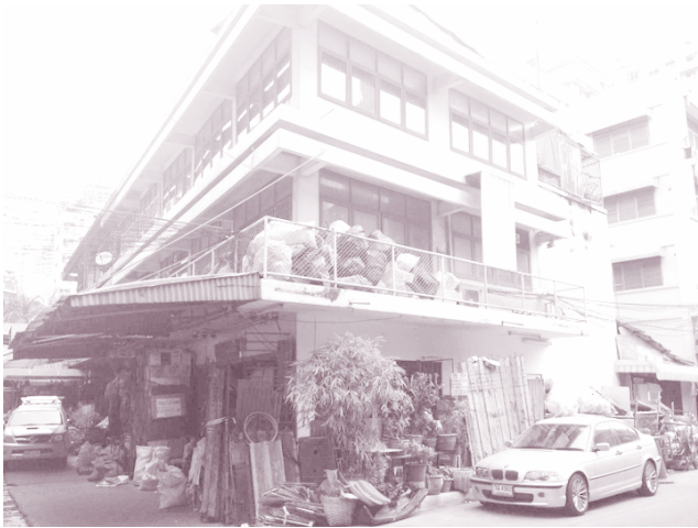
รูปที่ 2 การใช้พื้นยื่นไว้เก็บของต่างๆ ซึ่งต้องรับน้ำหนักค่อนข้างมาก
