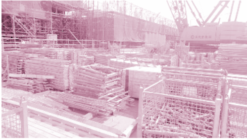
ภาพแสดงการจัดเก็บอุปกรณ์ไม้แบบนั่งร้านหน้างานก่อสร้างที่เป็นระเบียบเรียบร้อย
