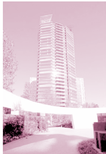
ภาพอาคาร Park Habio Shinjuku Eastside Tower
