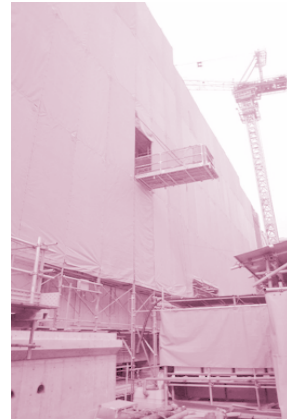
ภาพแสดงการติดตั้งแผงผ้าใบป้องกันฝุ่นรอบตัวอาคาร
