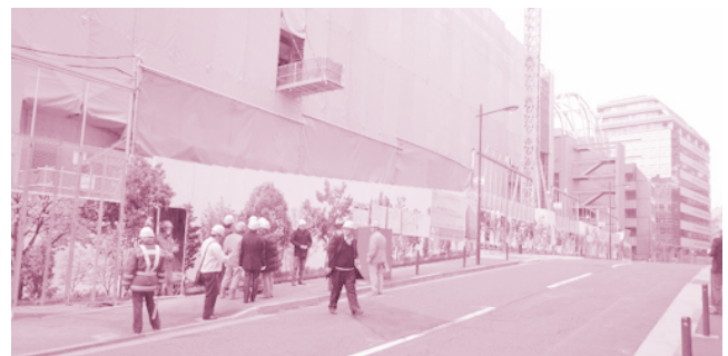
ภาพแสดงภาพรวมภายนอกโครงการก่อสร้าง Parkhouse GRAN Sanbancho
