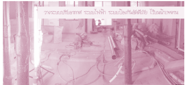
ภาพรวมการติดตั้งงานระบบภายในห้องชุด
