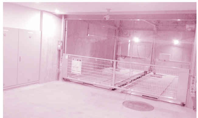
ภาพทางเข้าจอดรถระบบMechanic car parking
