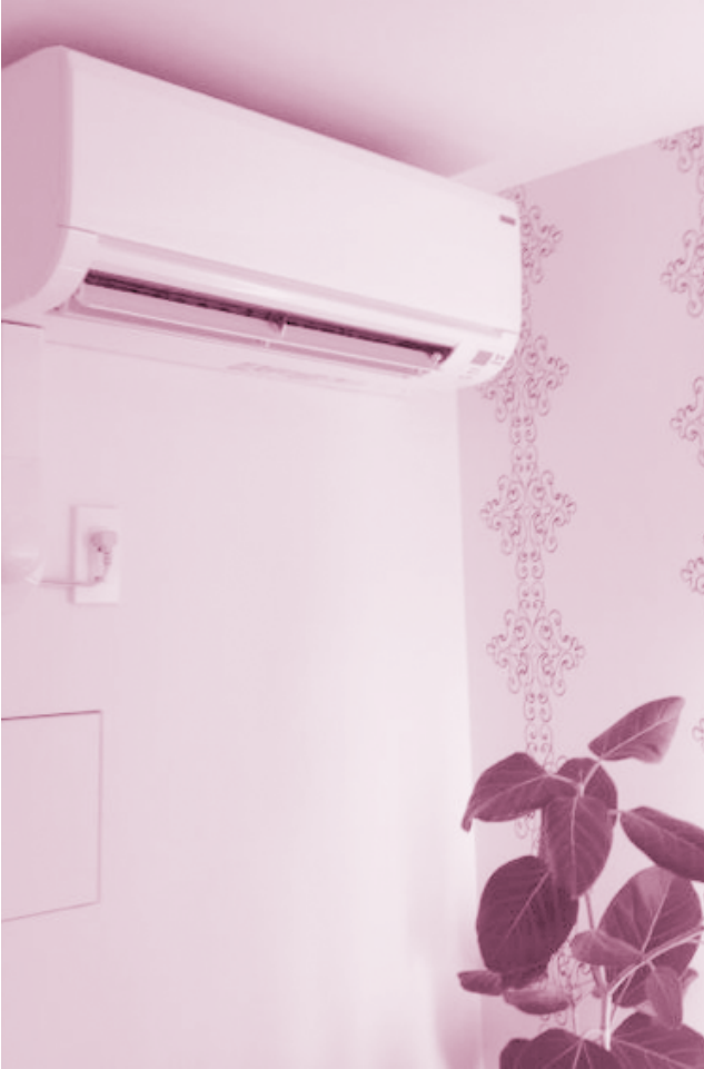
ภาพแสดงการติดตั้งเครื่องปรับอากาศ และช่อง service ที่ผนัง
