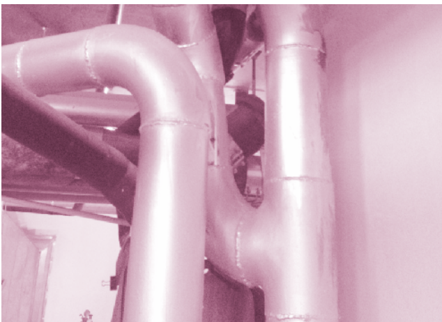
รูปการต่อชนเชื่อม(Butt Welded Joint)
