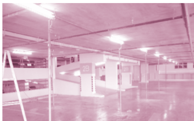
รูปที่ 2 การติดตั้งเสออ้างอิงที่ใต้พื้นทดสอบ และติดตั้งไดอัลเกจเพื่อใช้วัดระยะแอ่นตัวที่ท้องผิว
