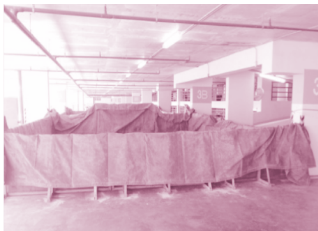
รูปที่ 1 การเตรียมทำบ่อน้ำชั่วคราวเพื่อใช้เก็บน้ำเป็นน้ำหนักบรรทุกทดสอบ
