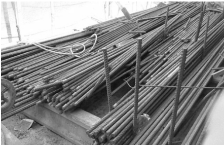
รูปภาพแสดงการจัดกองเหล็กเส้น โดยมีวัสดุรองมิให้สัมผัสพื้นโดยตรง และมีผ้าใบคลุมเมื่อหยุดใช้งาน
