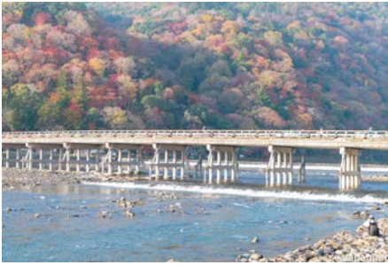
▲ สะพาน Togetsu-kyo ซึ่งจักรพรรดิ Kameyama ทรงตั้งชื่อเมื่อมาชม พระจันทร์เต็มดวงบนสะพาน
