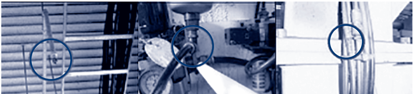
รูปแสดงจุดรั่วตามจุดต่าง ๆ เช่น ข้อต่อระหว่างท่อกับอุปกรณ์ ท่อทางเดินที่มีการต่อแยกไปใช้ และท่อที่เก่า
