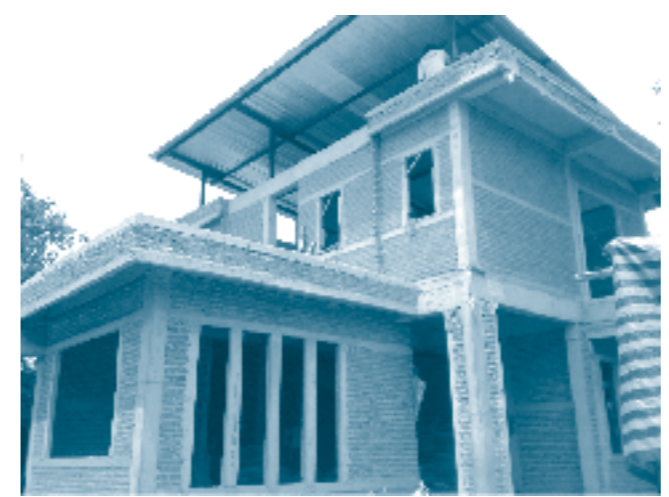
รูปภาพแสดงเสาเอ็น-คานทับหลัง
